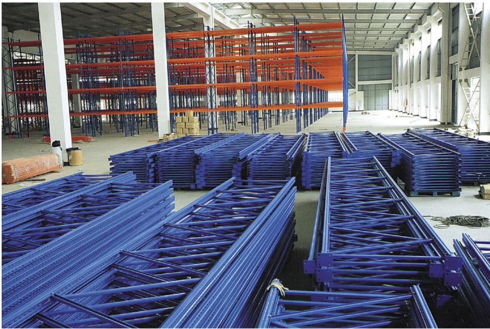
安装现场 Installation site
