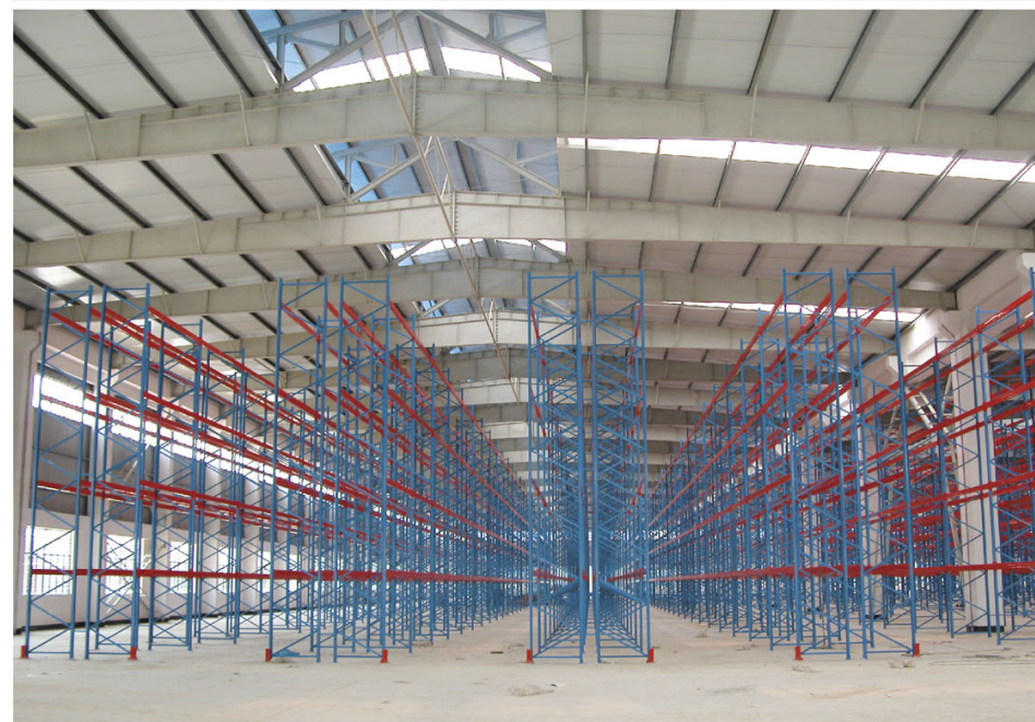
佛山照明高明仓由大昌公司承建。
