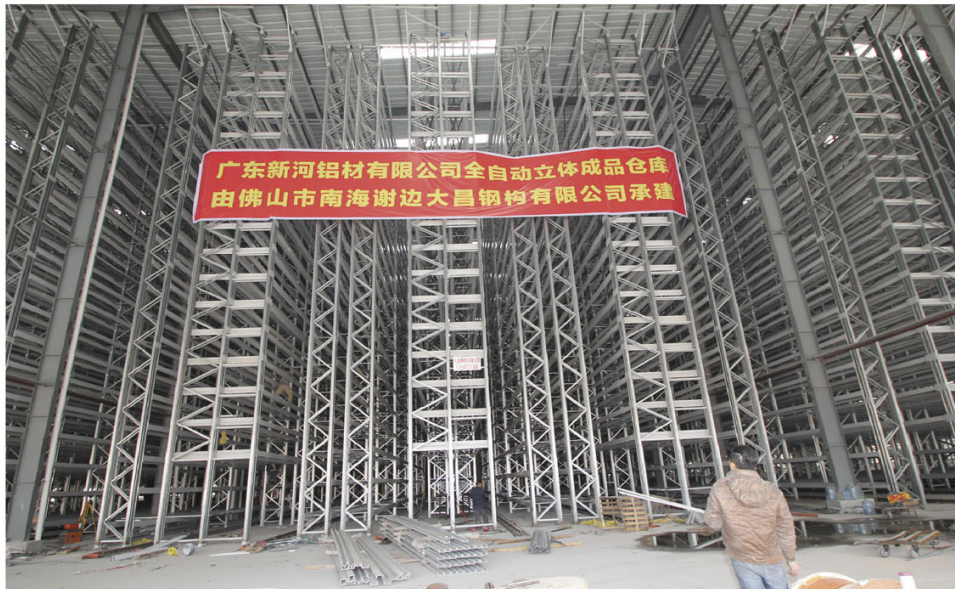
新河铝材安装现场
